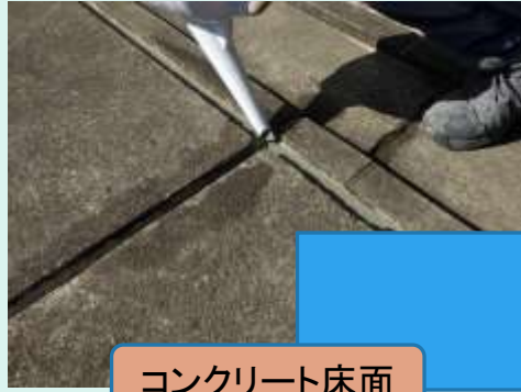
コンクリート床面
