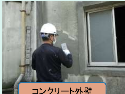
コンクリート外壁
